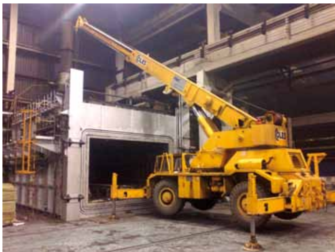
Auto dizalica Tehnike d.o.o na montaži opreme na peći V-5/5
